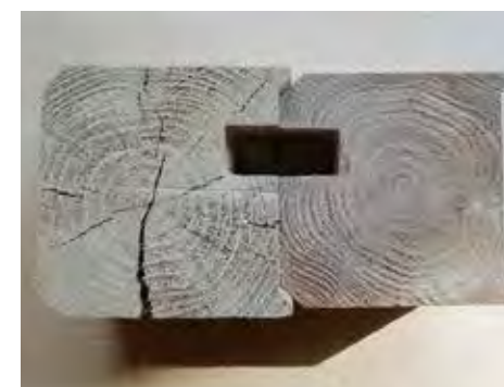
配線用加工を施したログ材断面
