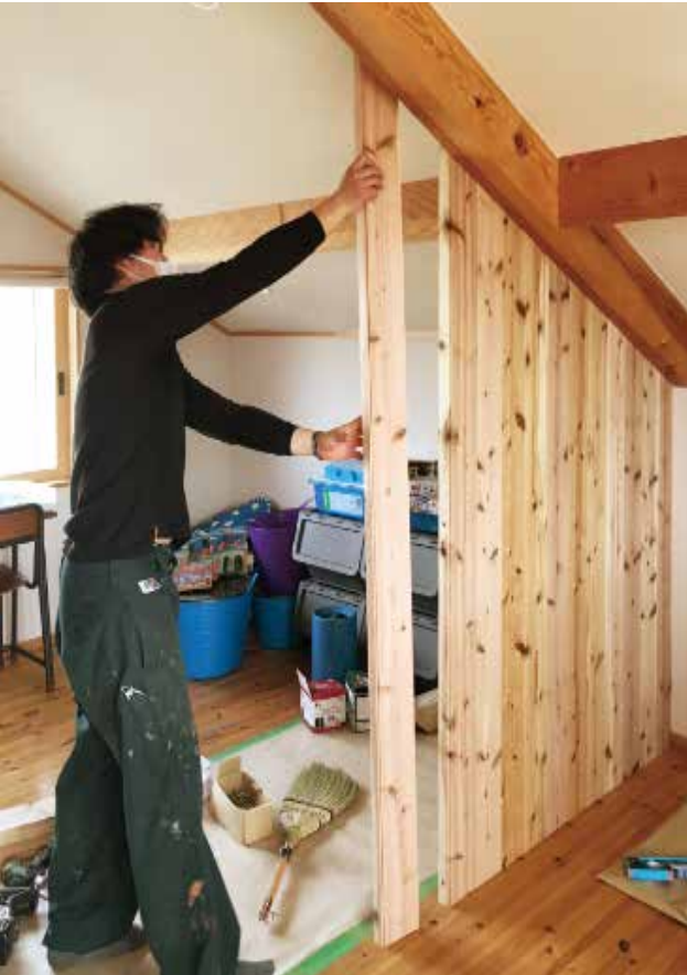
新たに部屋を間仕切る作業の様子
