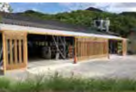
パネルログ工場の新設
