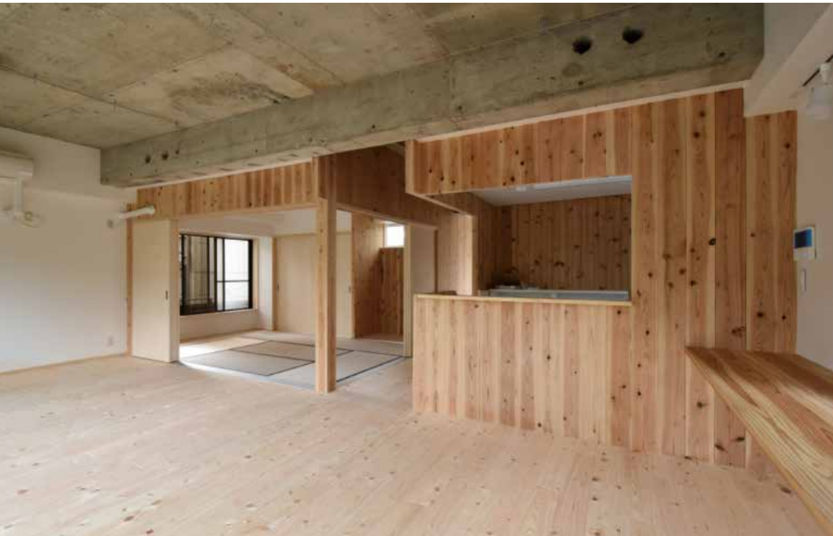
鉄筋コンクリート造の建物のリフォーム（外壁や間仕切壁にパネルログを採用）
