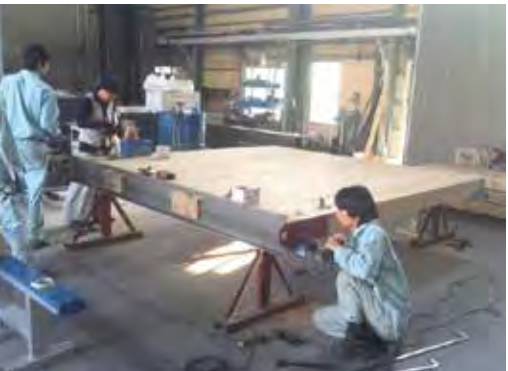
試験体組立の様子
