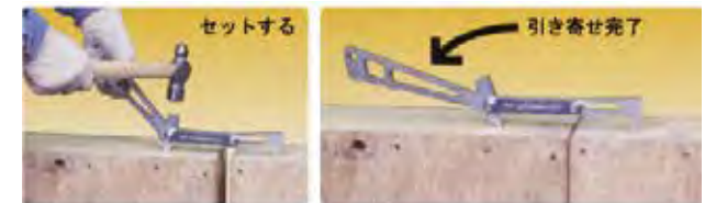
引き寄せ工具等を用いて、パネルを引き寄せる
