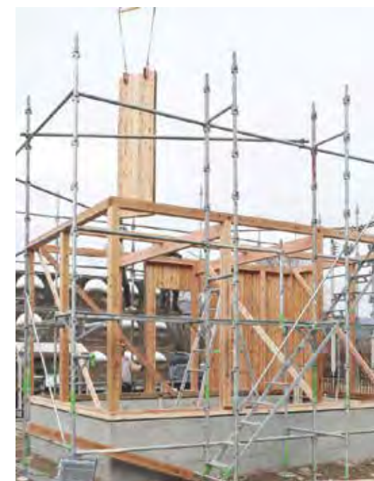
「外ベタパネル」壁の施工の様子
