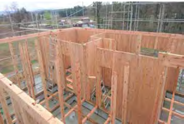
柱間パネルの施工の様子
