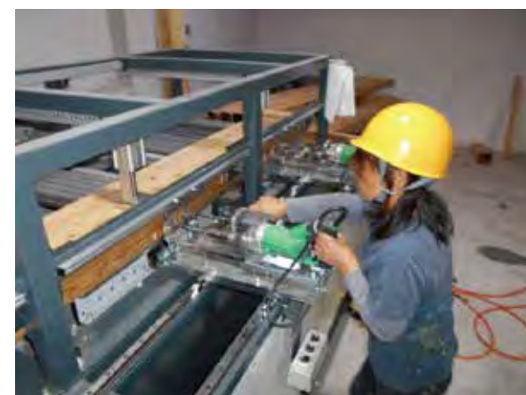
ビス打ち工程の様子
