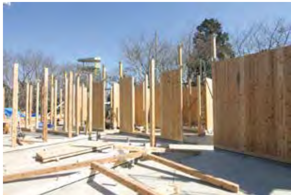
柱間パネルと軸組材の施工の様子
