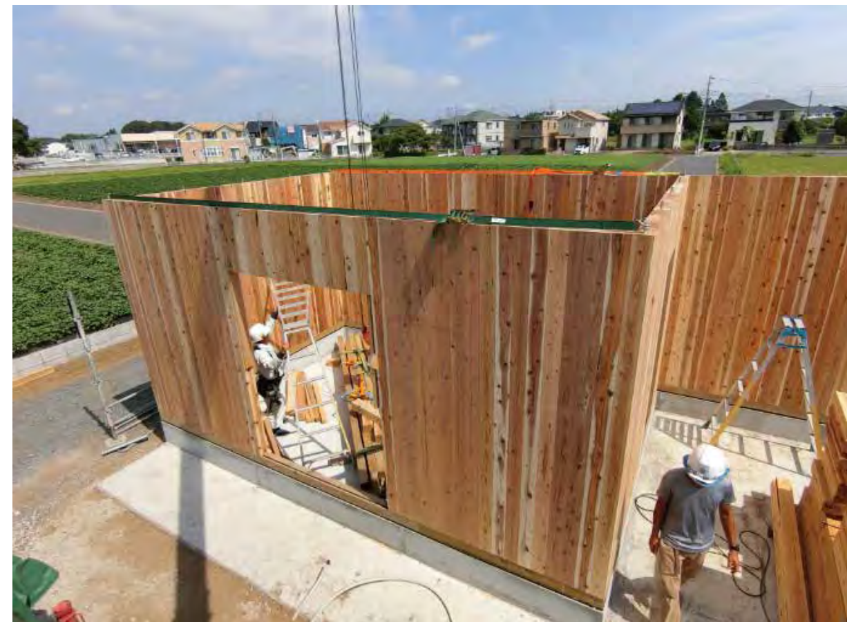
ラッシングを用いて、パネルと柱を締め付けて、調整している様子
