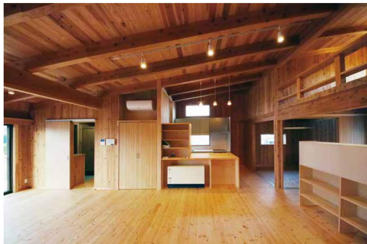
パネルログ構法による住宅の例
