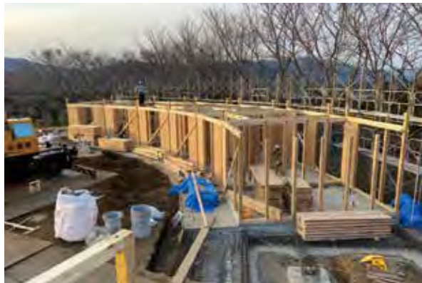
施工現場の様子
