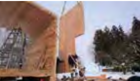
クロスログ構法の開発、試作
