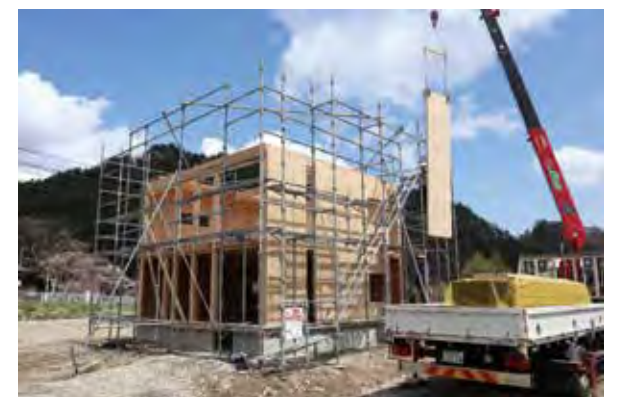
4m壁パネル 施工の様子
