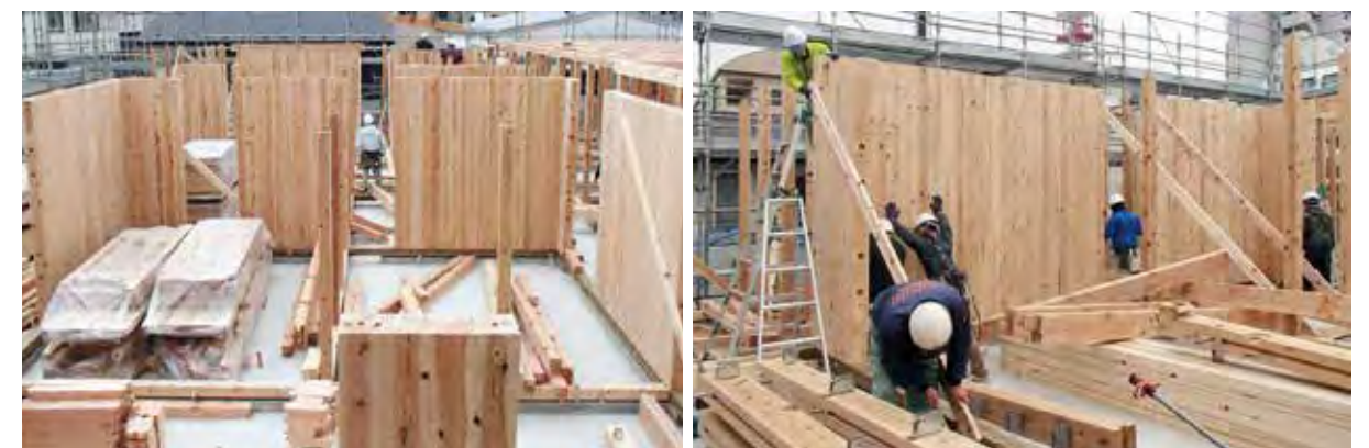
壁パネル 施工の様子
