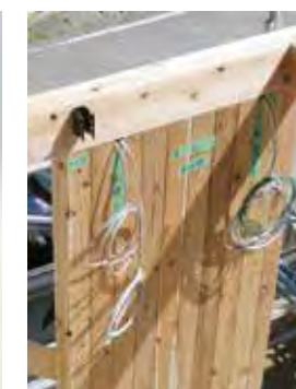
設備配線施工の様子
