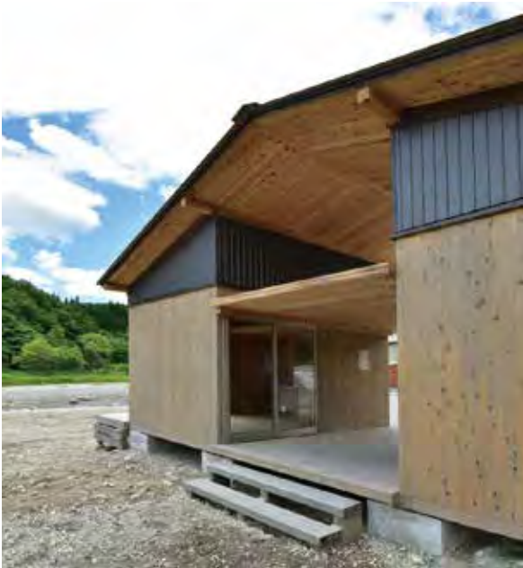
建物を繋ぐウッドデッキ 厚み 105mm
