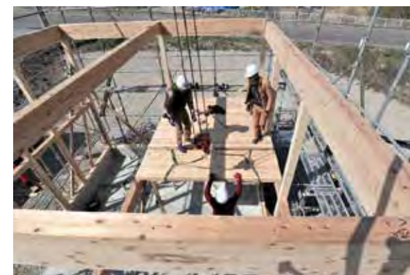
2階床パネル 施工の様子
