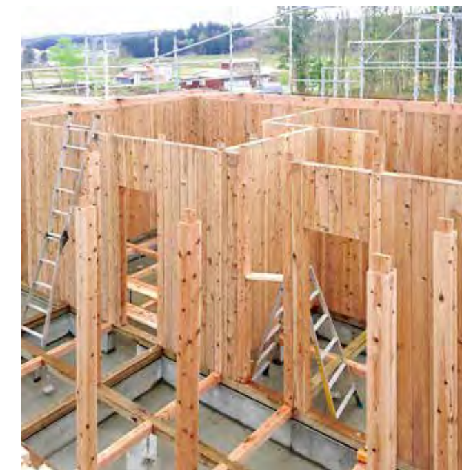
「柱間パネル」壁の施工の様子
